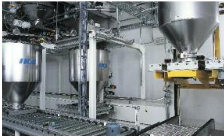
Odważanie do zbiornika miksującego
